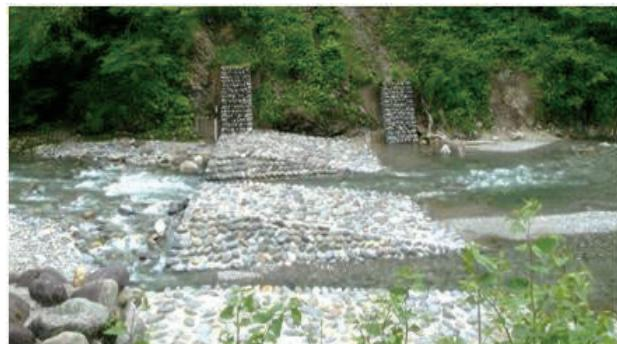
図-1. 透過型砂防堰堤
