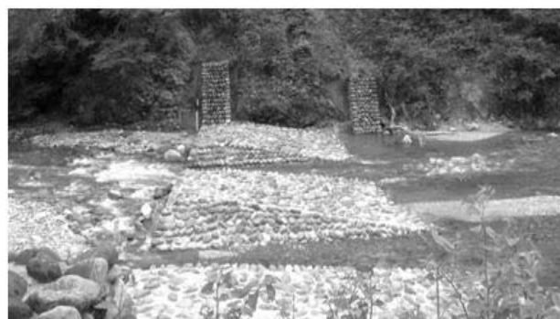
図-1. 透過型砂防堰堤
